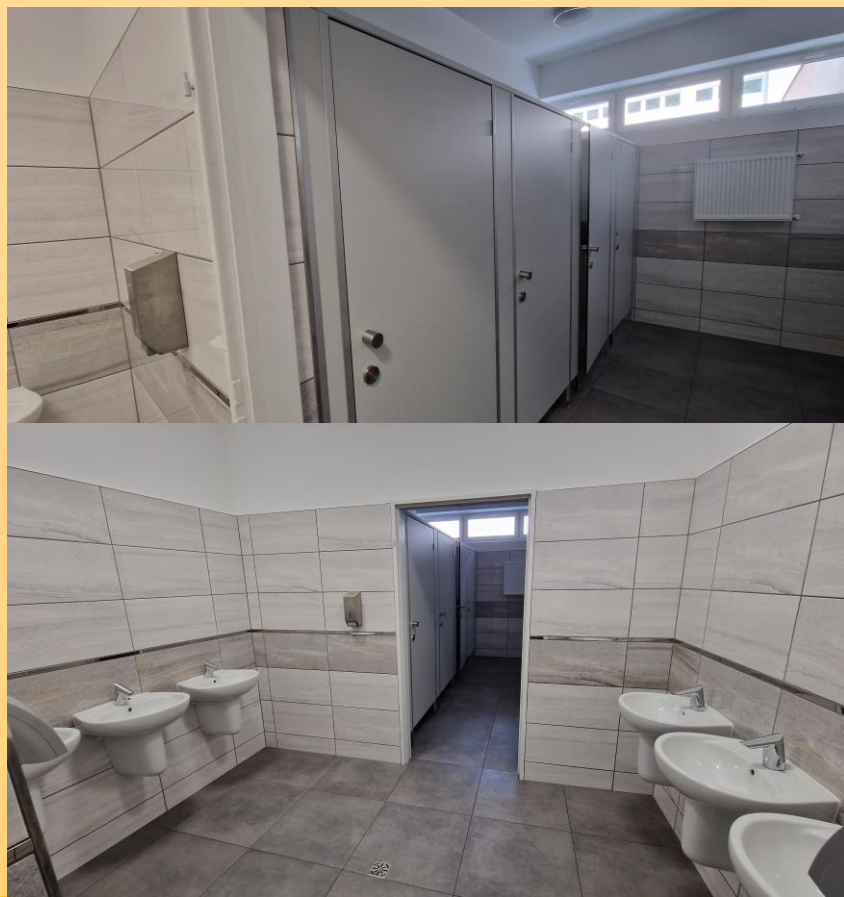
Remont toalet w szkole nr 5 261 000 zł
