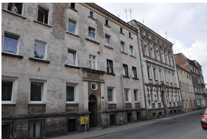
Zdjęcie 3 Jedna z kamienic przy ul. Damrota przed remontem. Źródło: Urząd Miejski w Kluczborku.
