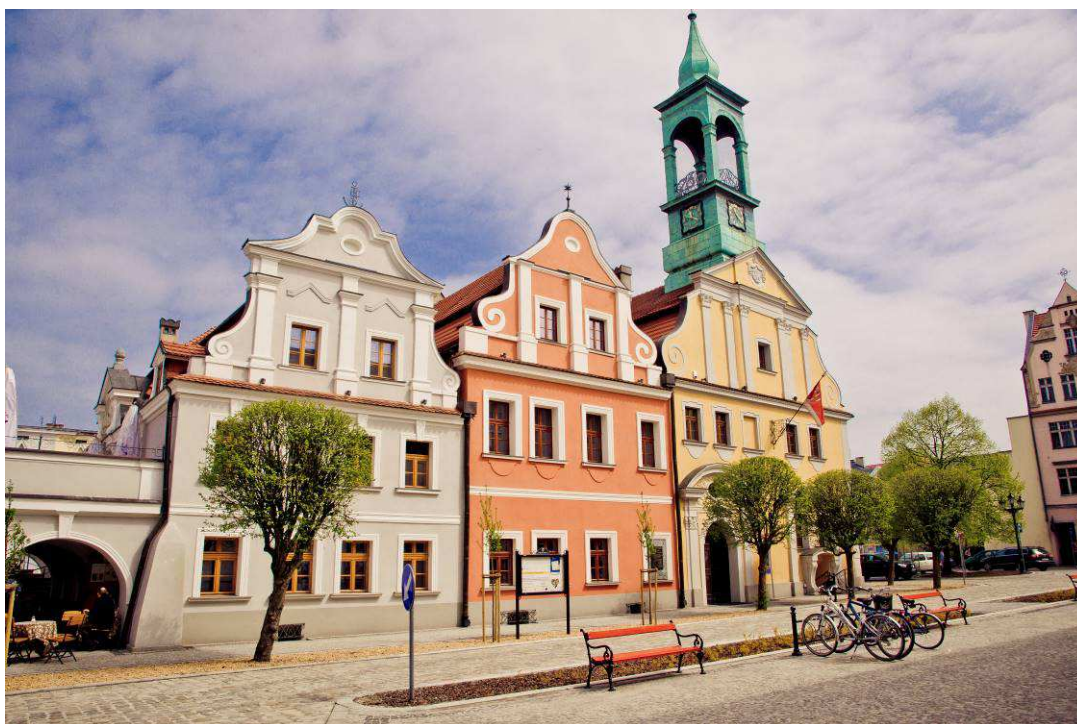
Zdjęcie nr 2 wyremontowany Ratusz Miejski
