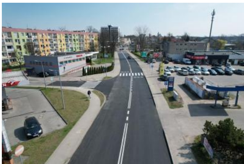
Remont ul. Wolczyńskiej
