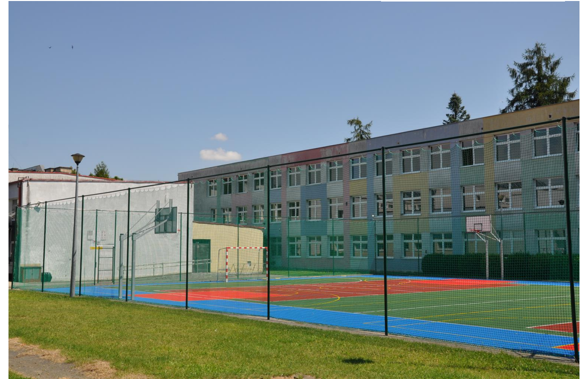
PSP nr 5 w Kluczborku Boisko i ogrodzenie boiska wielofunkcyjnego 175 343 zł 2020
