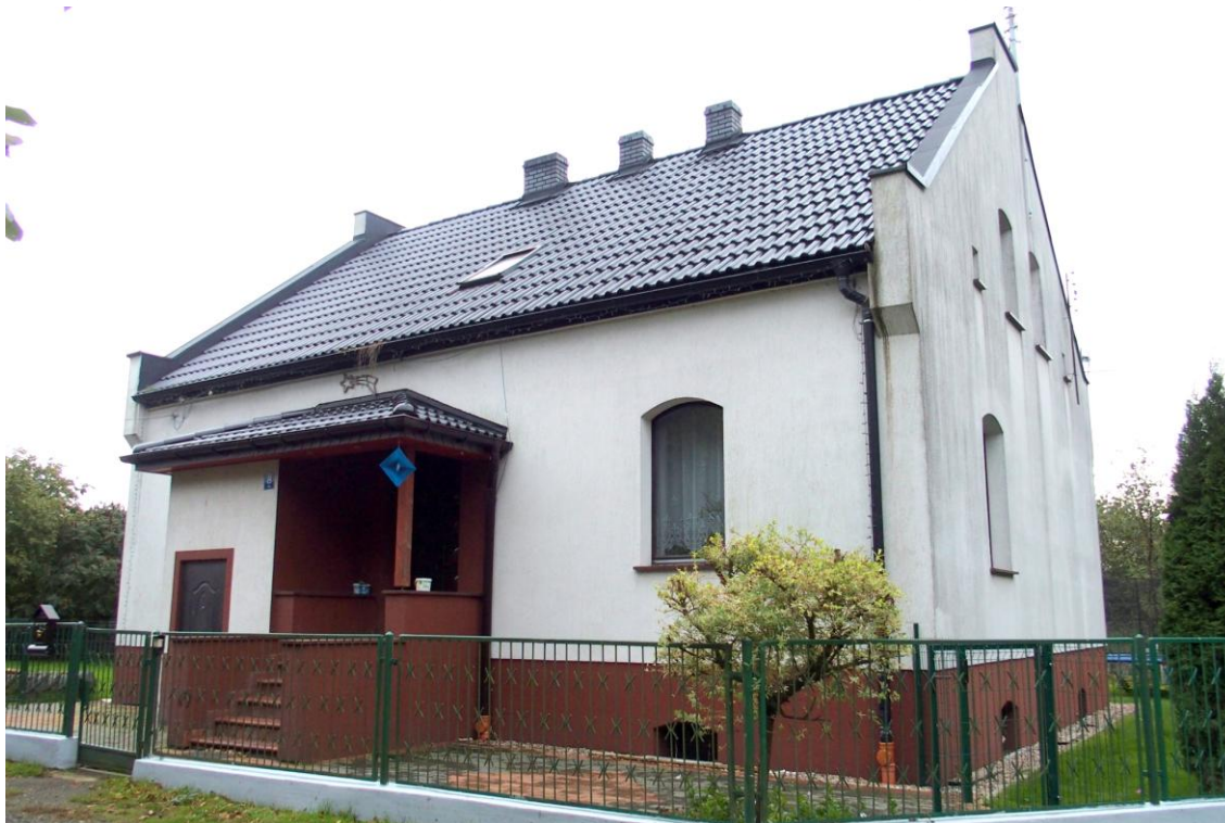
Widok budynku od północy
