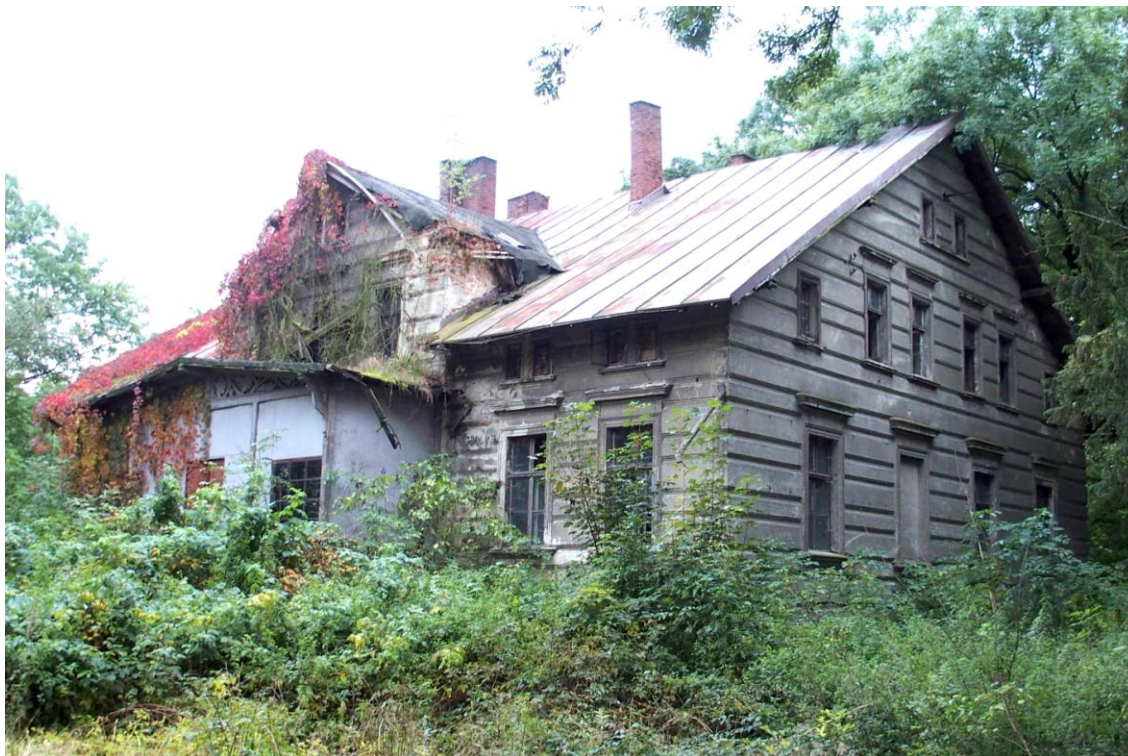
Widok budynku od północnego - wschodu
