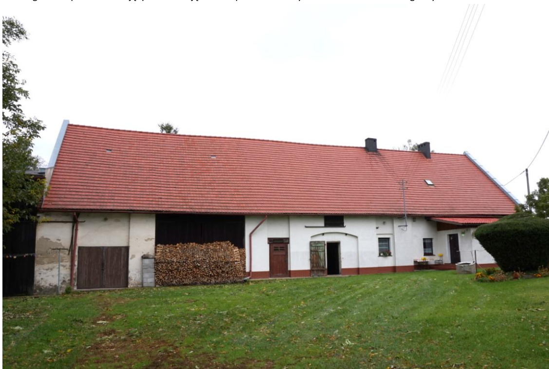
Widok budynku od południa
