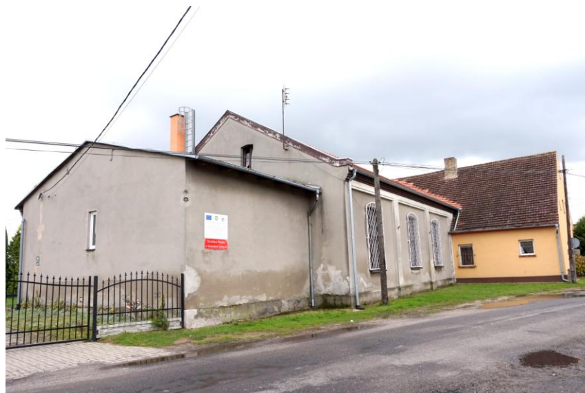
Widok budynku od północnego - zachodu
