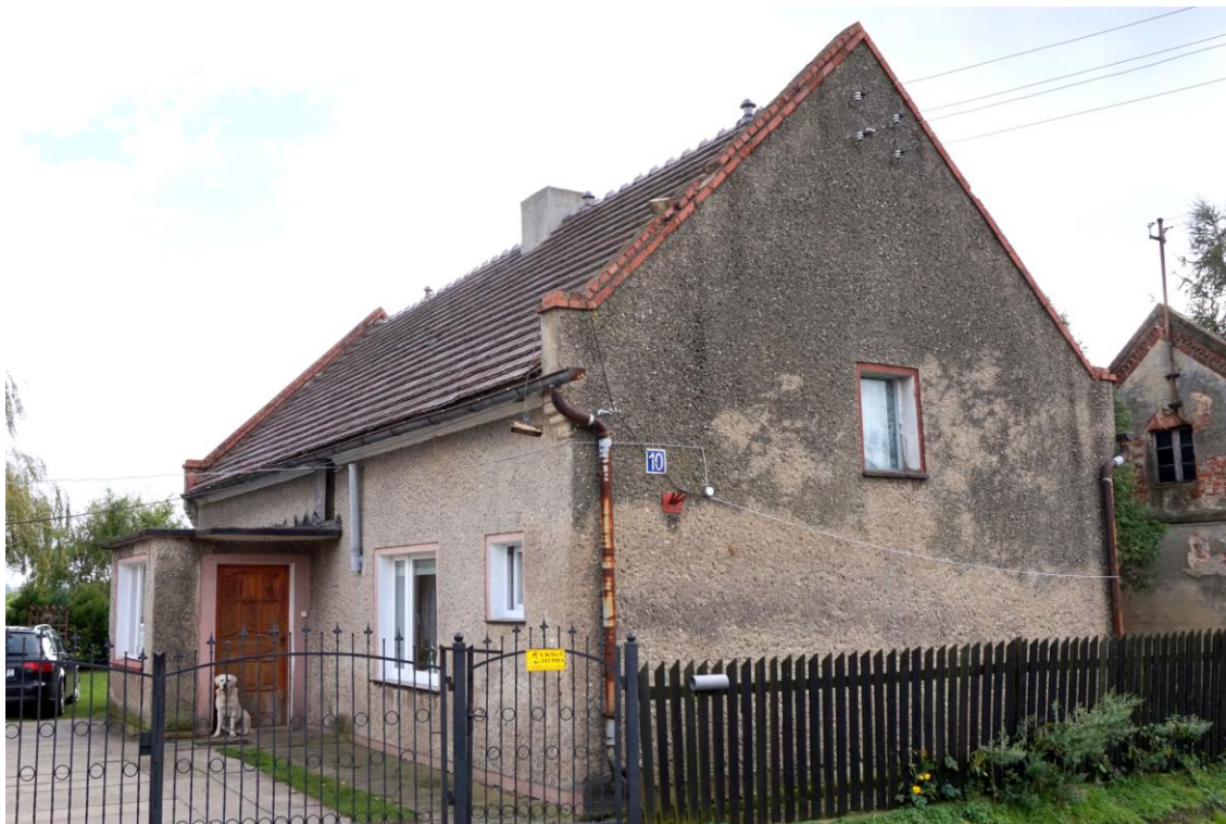
Widok budynku od północy
