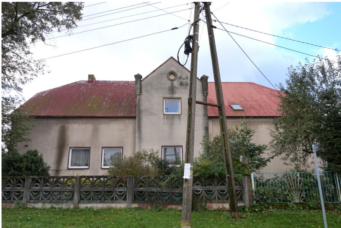
Widok budynku od północy
