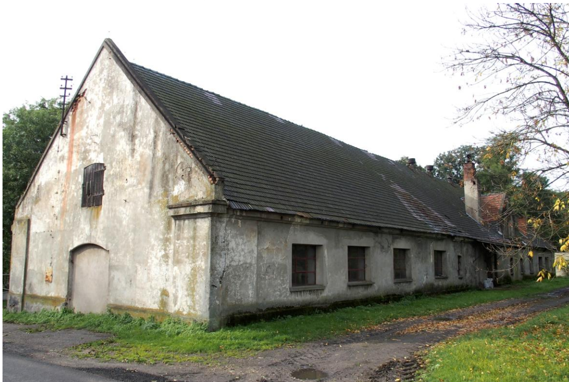
Widok budynku od północnego - wschodu
