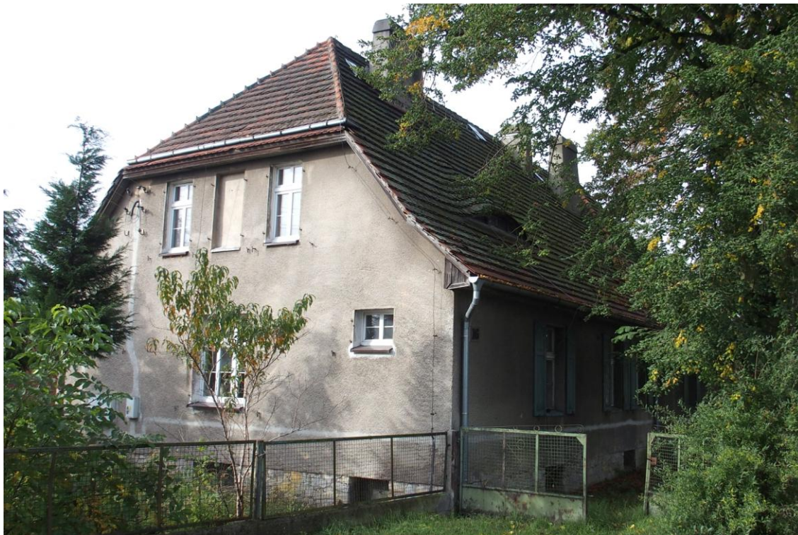
Widok budynku od wschodu
