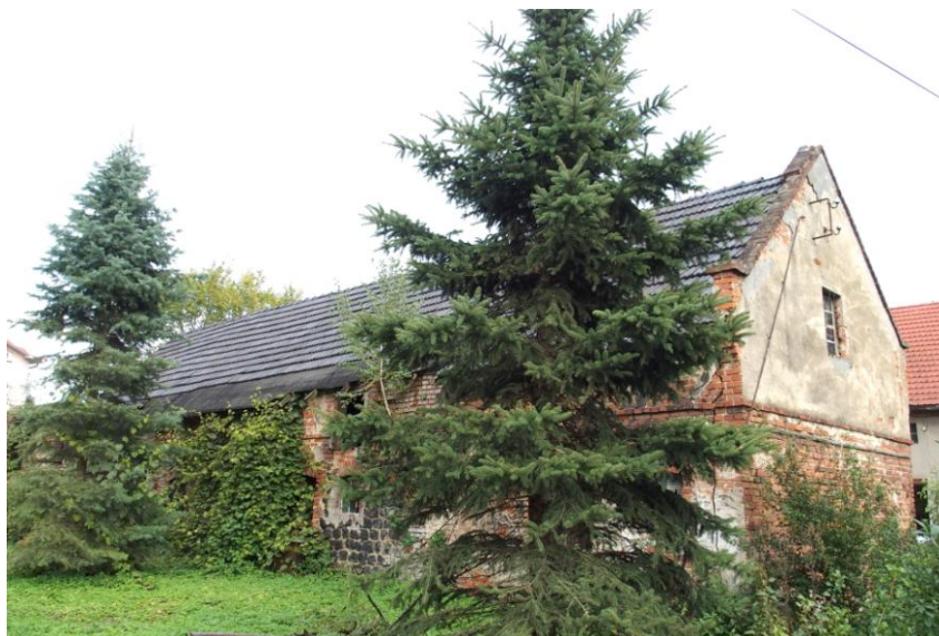
Widok budynku od południowego - zachodu
