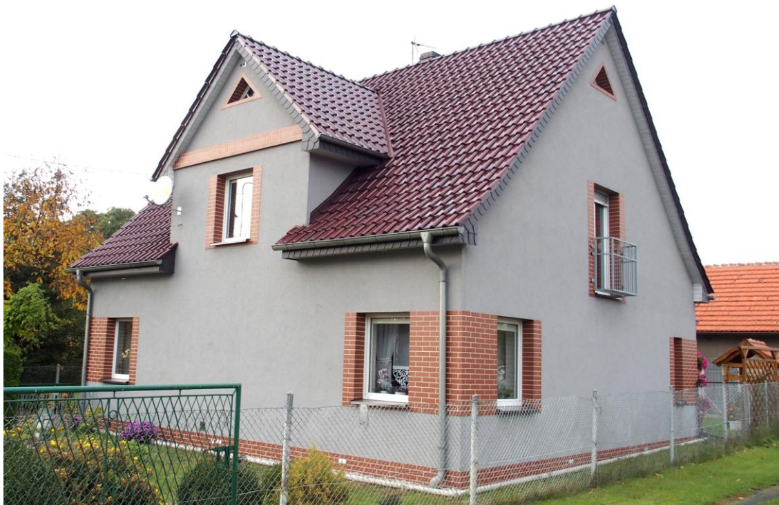
Widok budynku od południowego - wschodu
