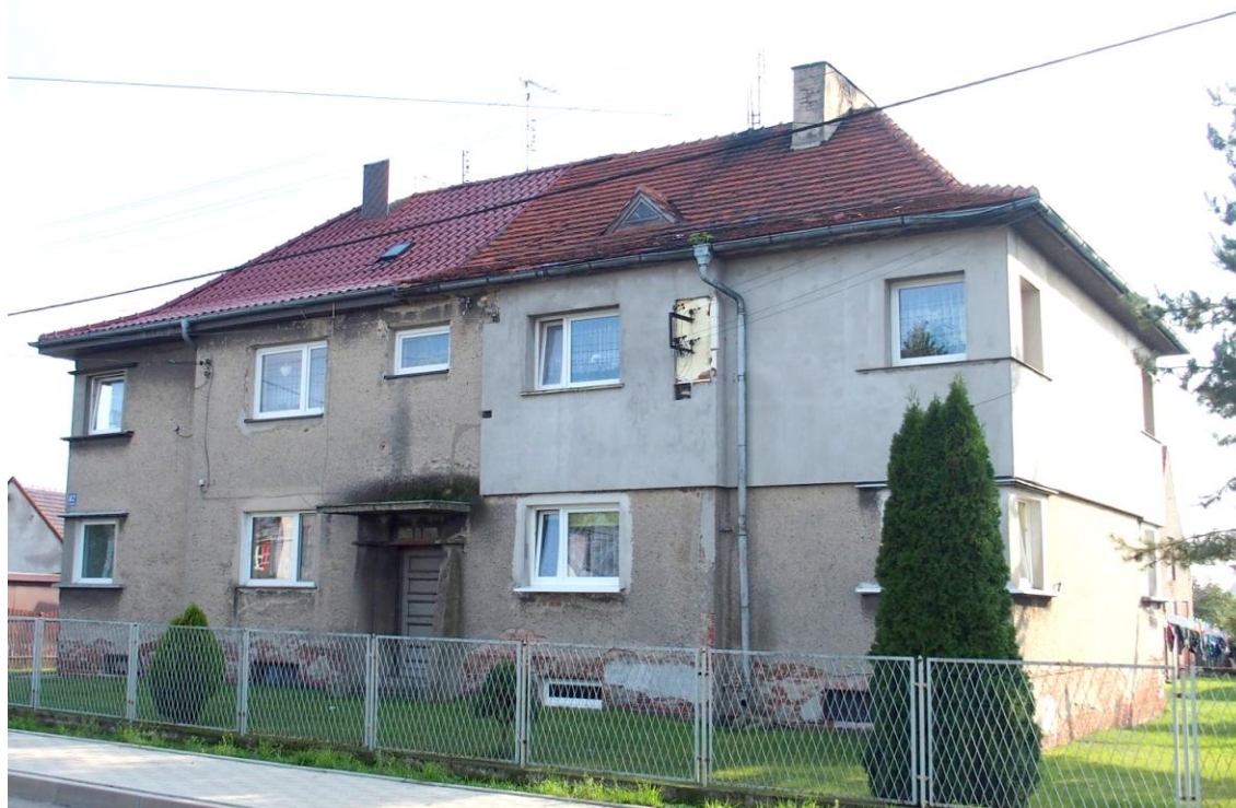
Widok budynku od północy
