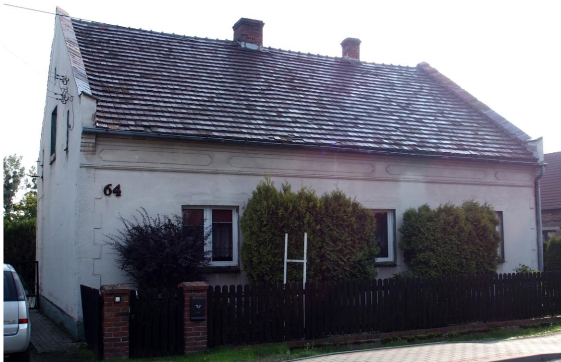
Widok budynku od północy
