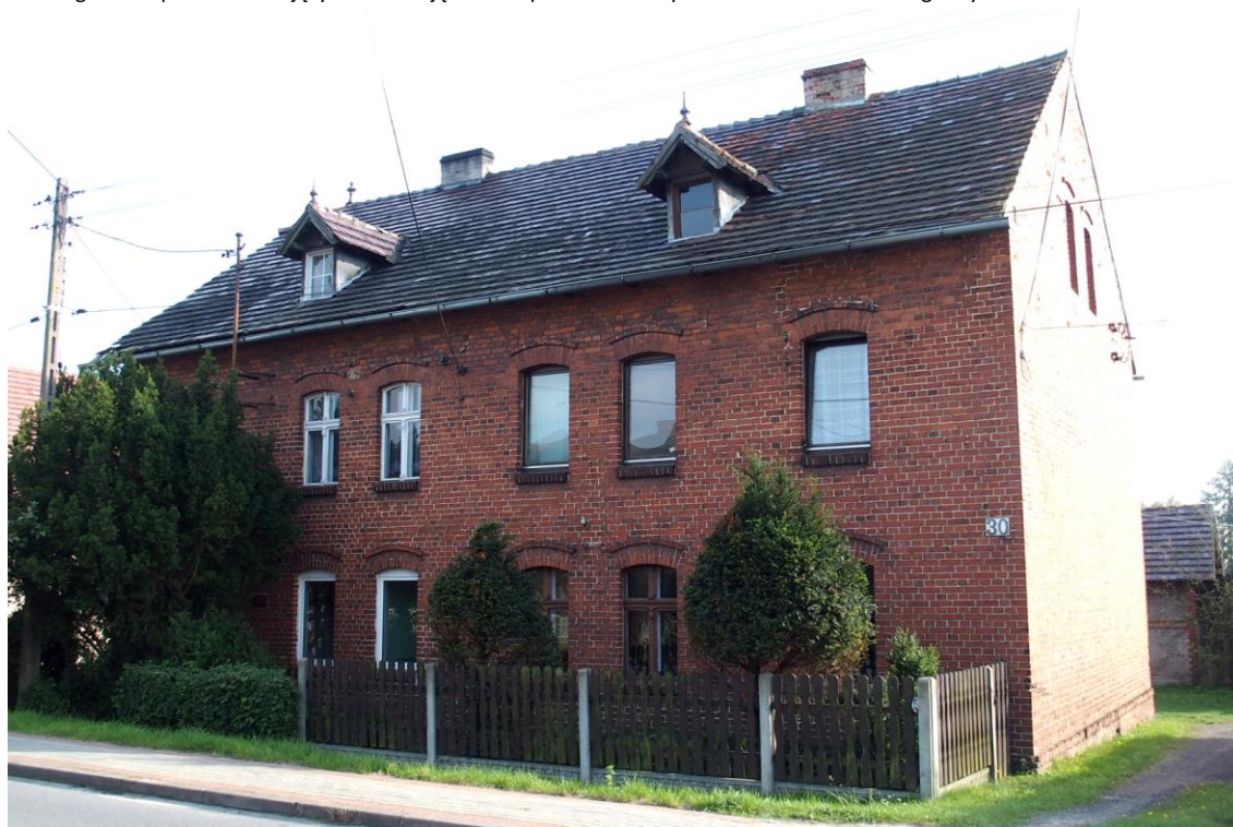
Widok budynku od północy
