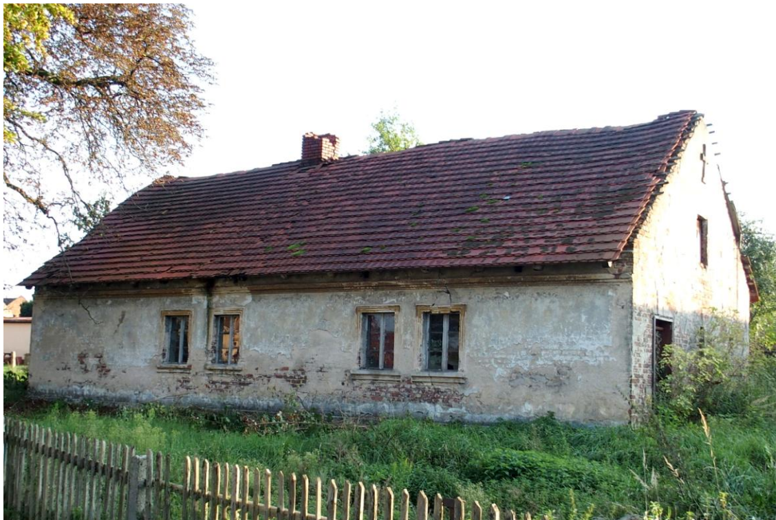
Widok budynku od północy
