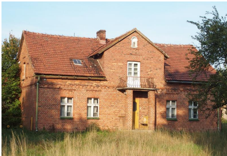
Widok budynku od południowego - zachodu
