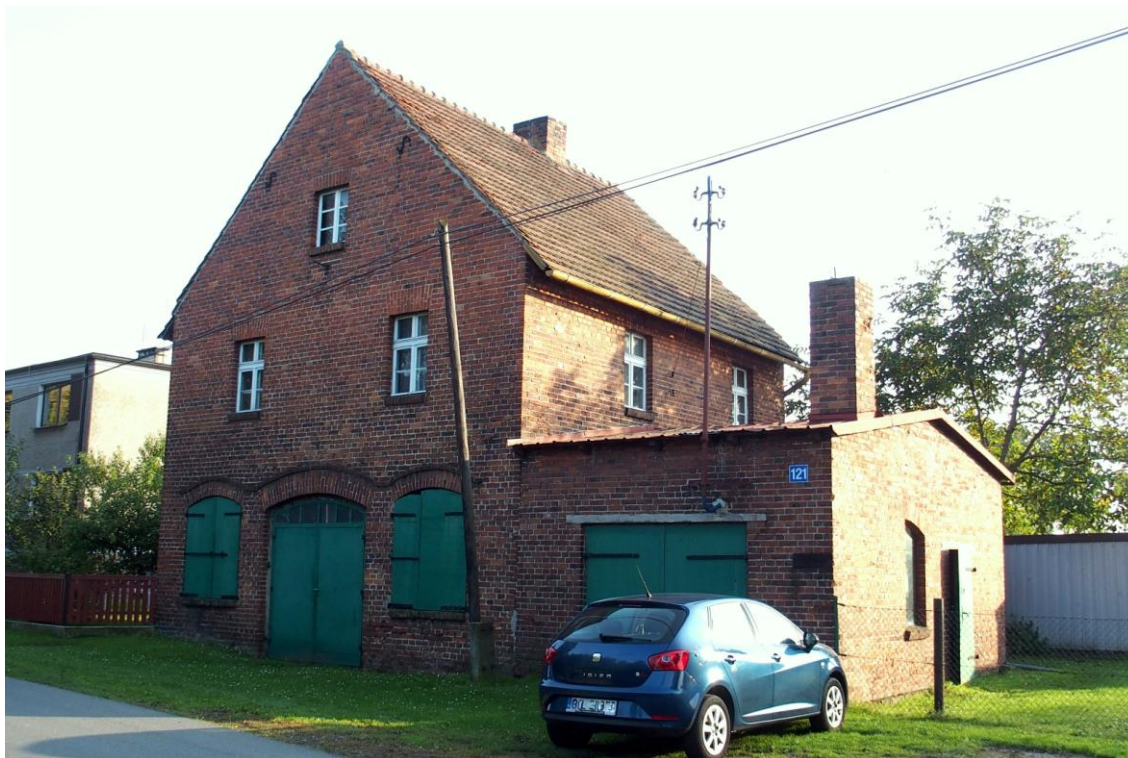
Widok budynku od północy
