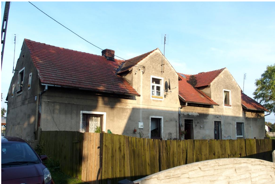
Widok budynku od zachodu
