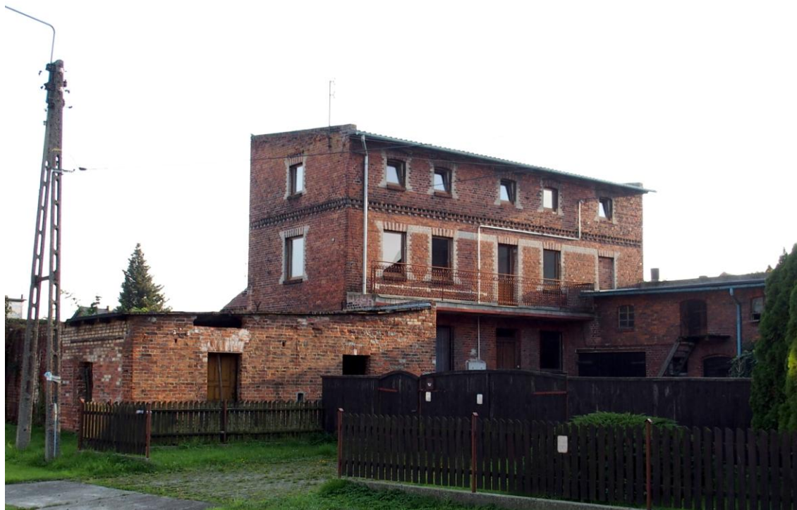
Widok budynku od północy
