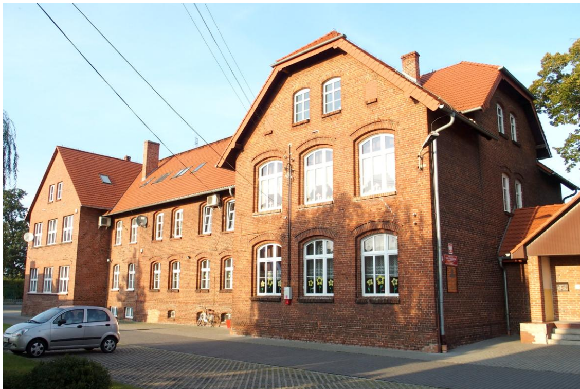
Widok budynku od południowego - zachodu
