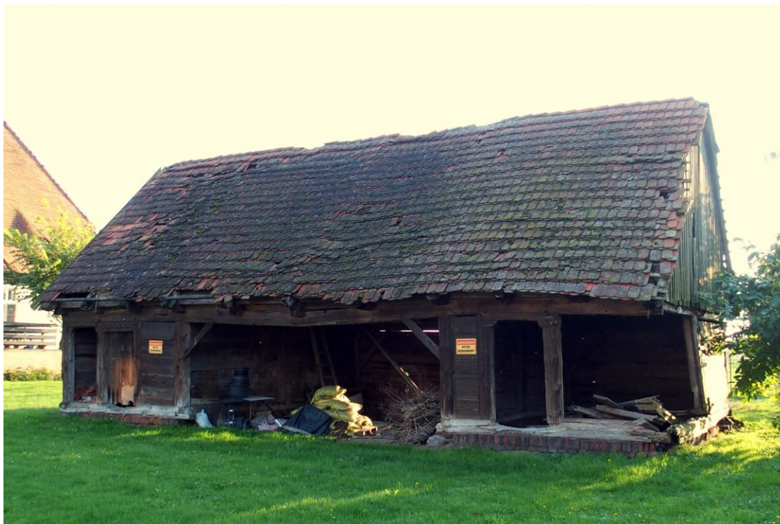
Widok budynku od północnego - wschodu
