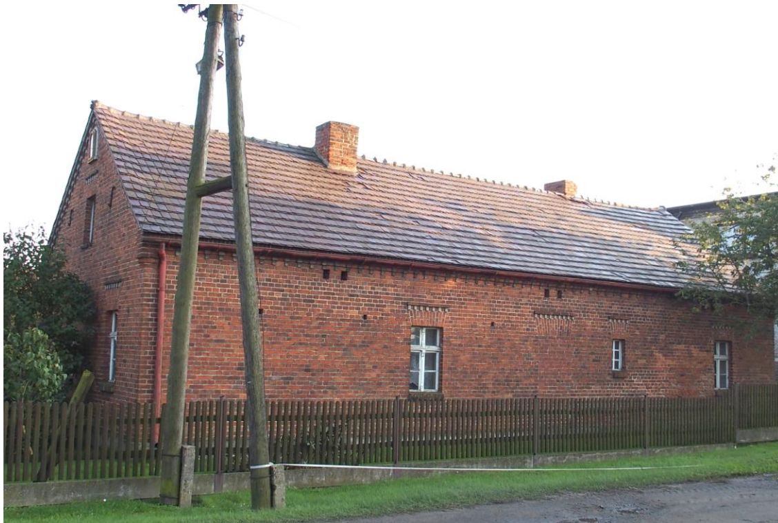
Widok budynku od północy
