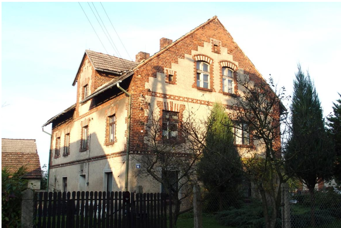
Widok budynku od południowego - zachodu
