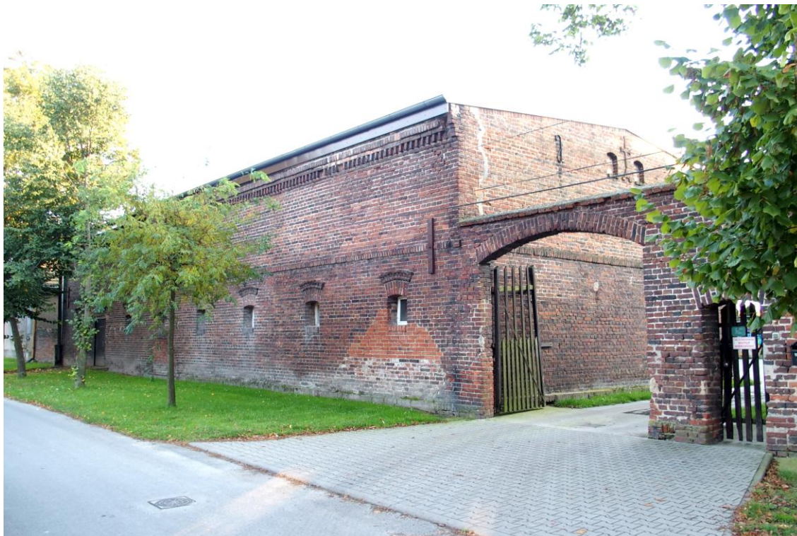
Widok budynku od północy
