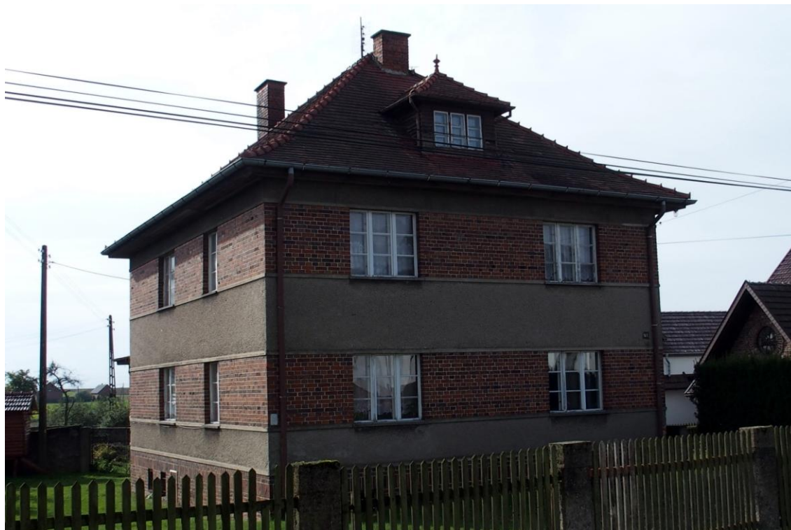
Widok budynku od północy
