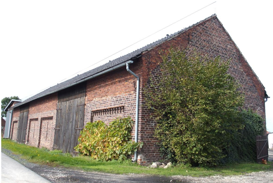
Widok budynku od południowego - wschodu
