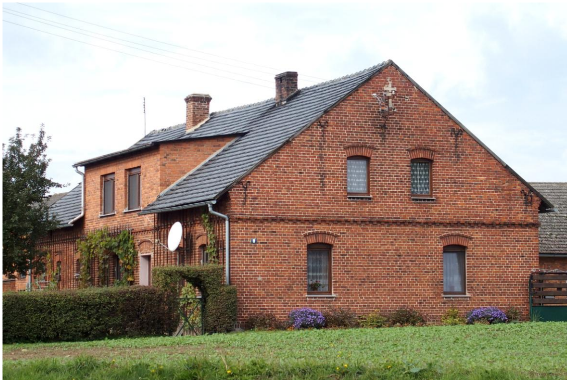
Widok budynku od południowego - wschodu
