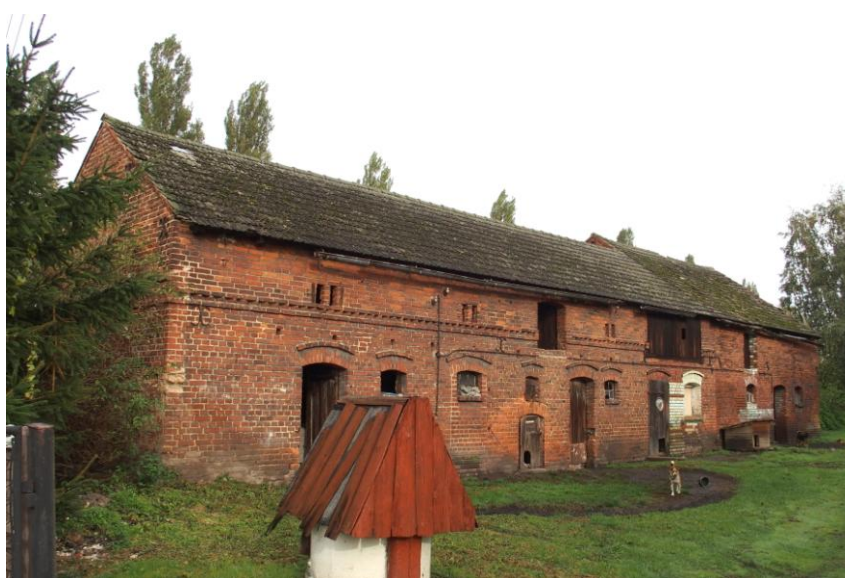
Widok budynku od południowego - wschodu
