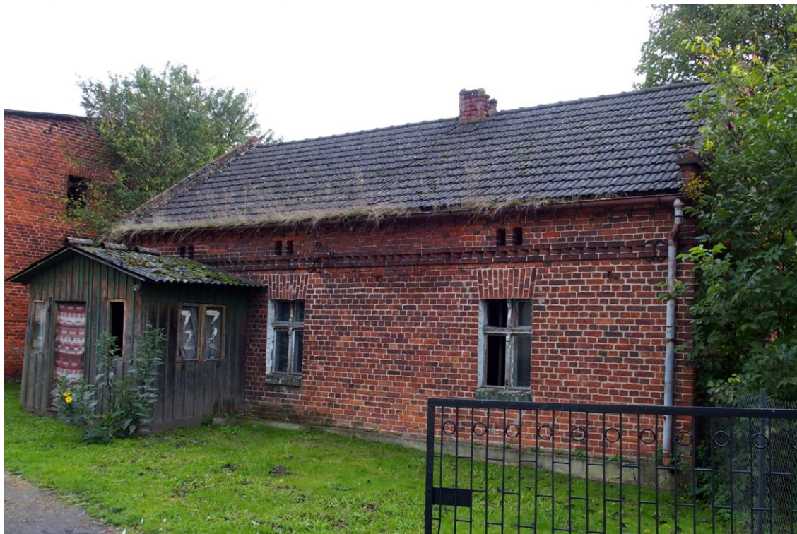
Widok budynku od południowego - zachodu
