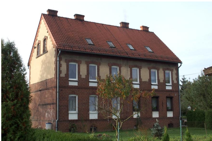
Widok budynku od północy
