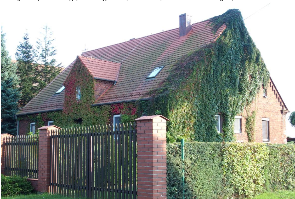
Widok budynku od północnego - zachodu
