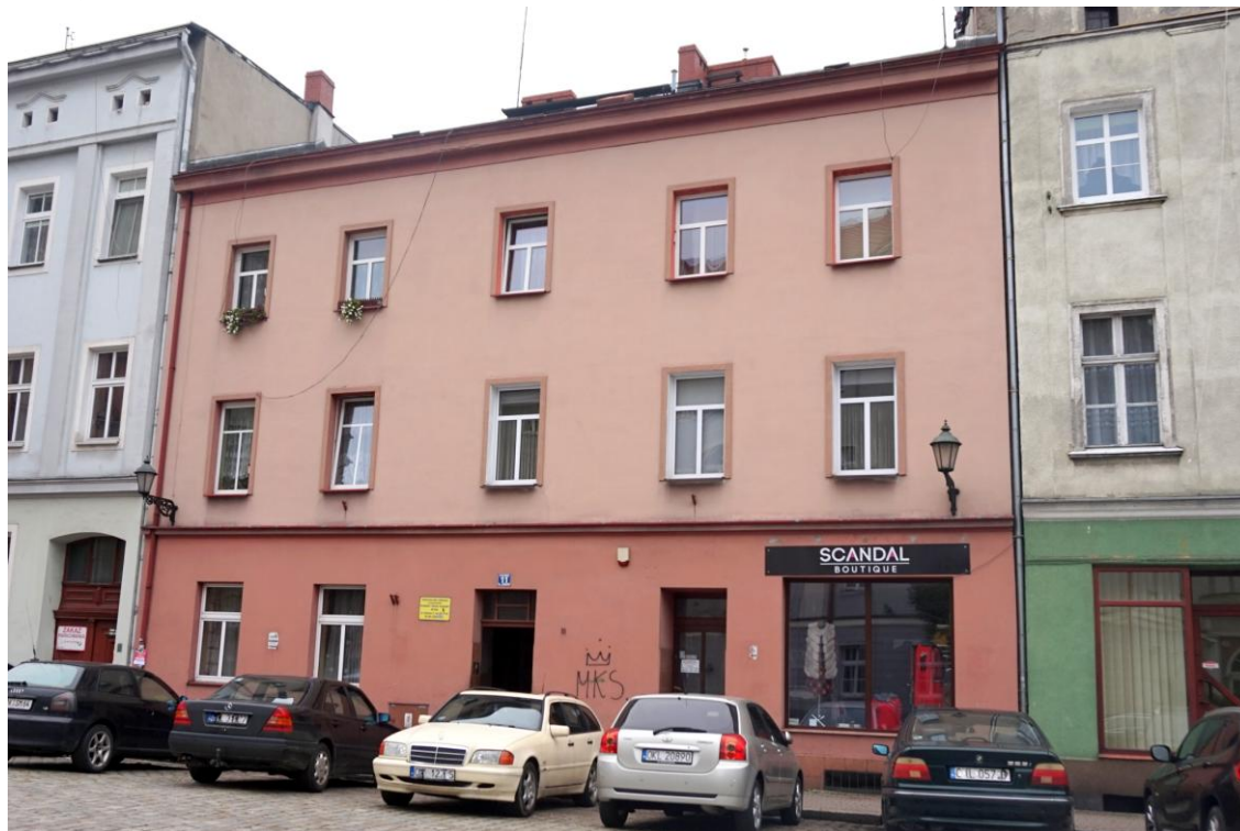
Widok budynku od północy
