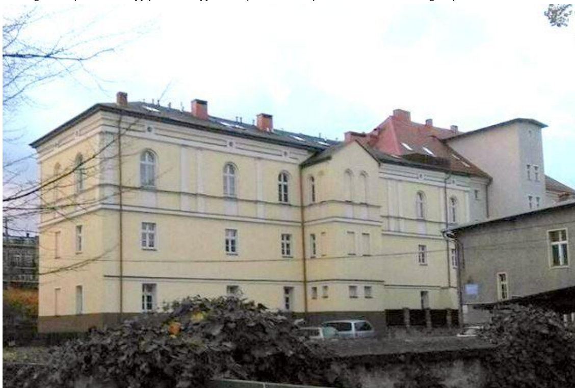
Widok budynku od północnego - wschodu
