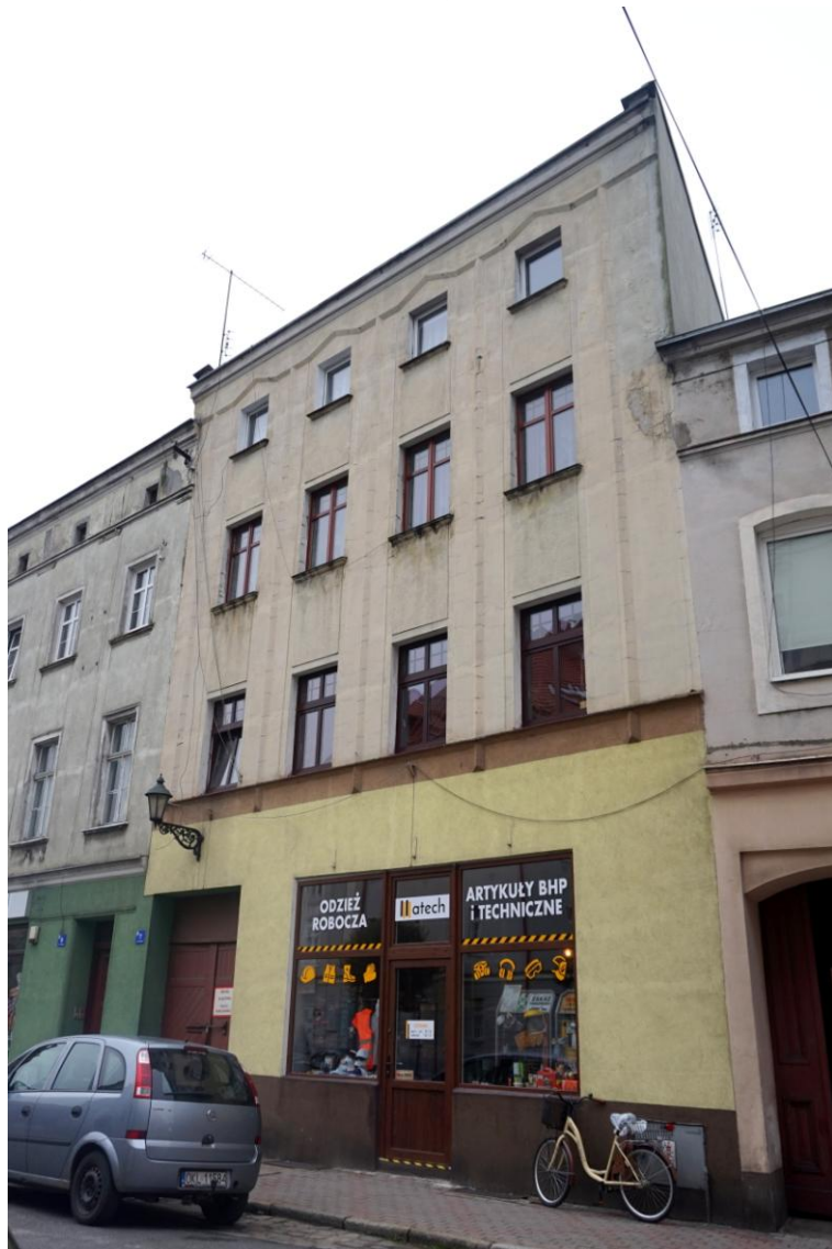
Widok budynku od północy
