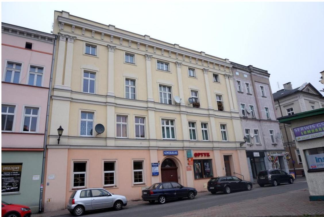
Widok budynku od południa
