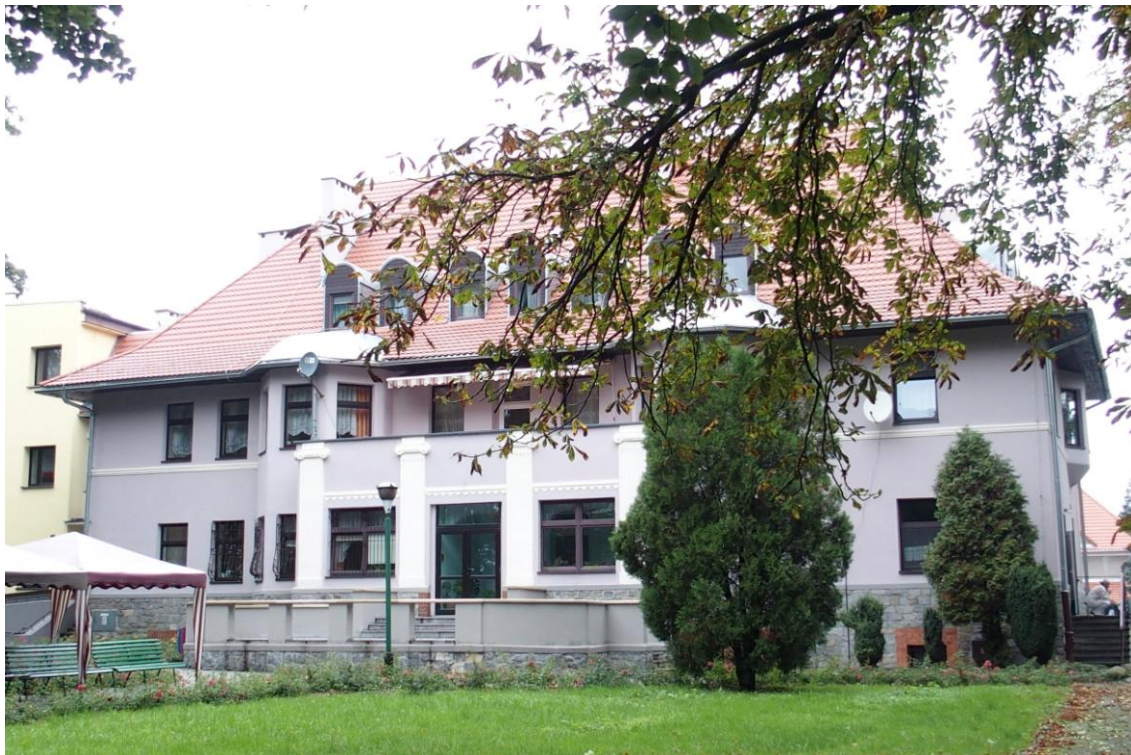
Widok budynku od południa
