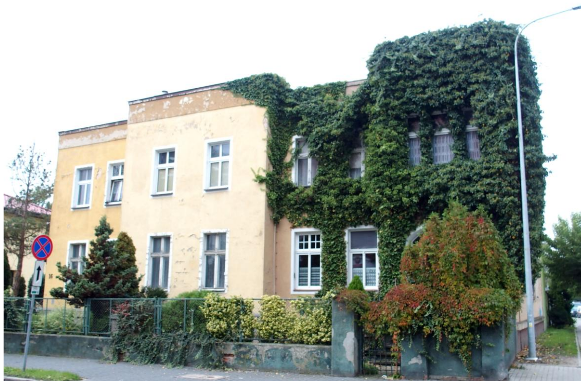
Widok budynku od wschodu
