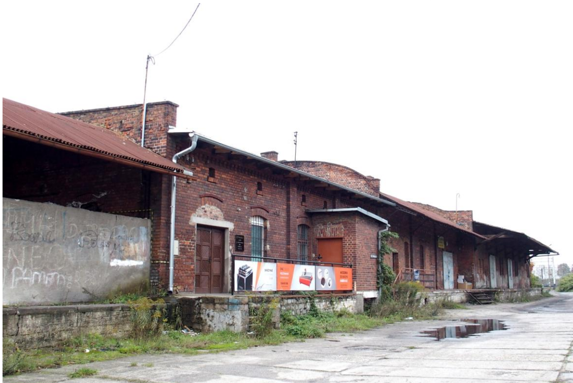
Widok budynku od wschodu
