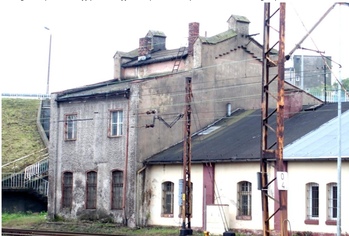
Widok budynku od północy
