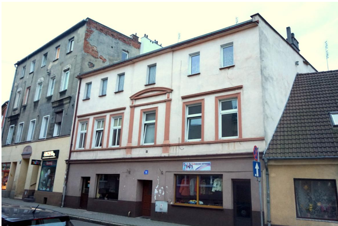
Widok budynku od północy
