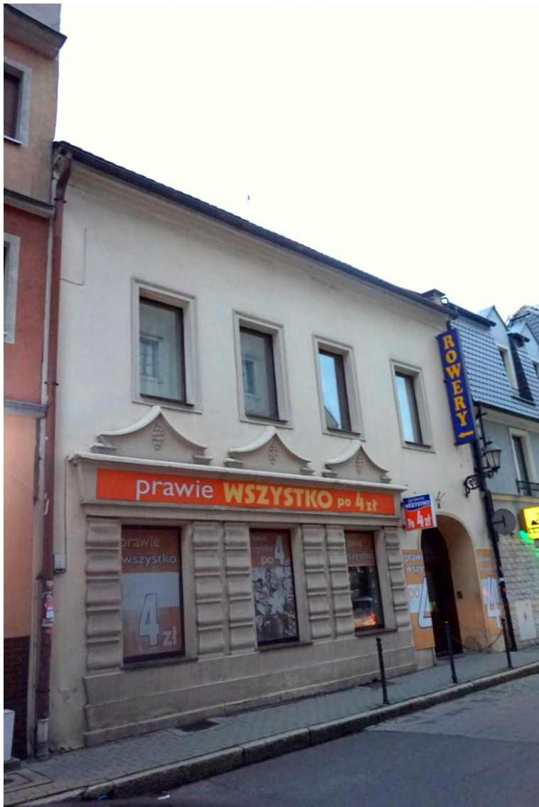
Widok budynku od południowego - zachodu
