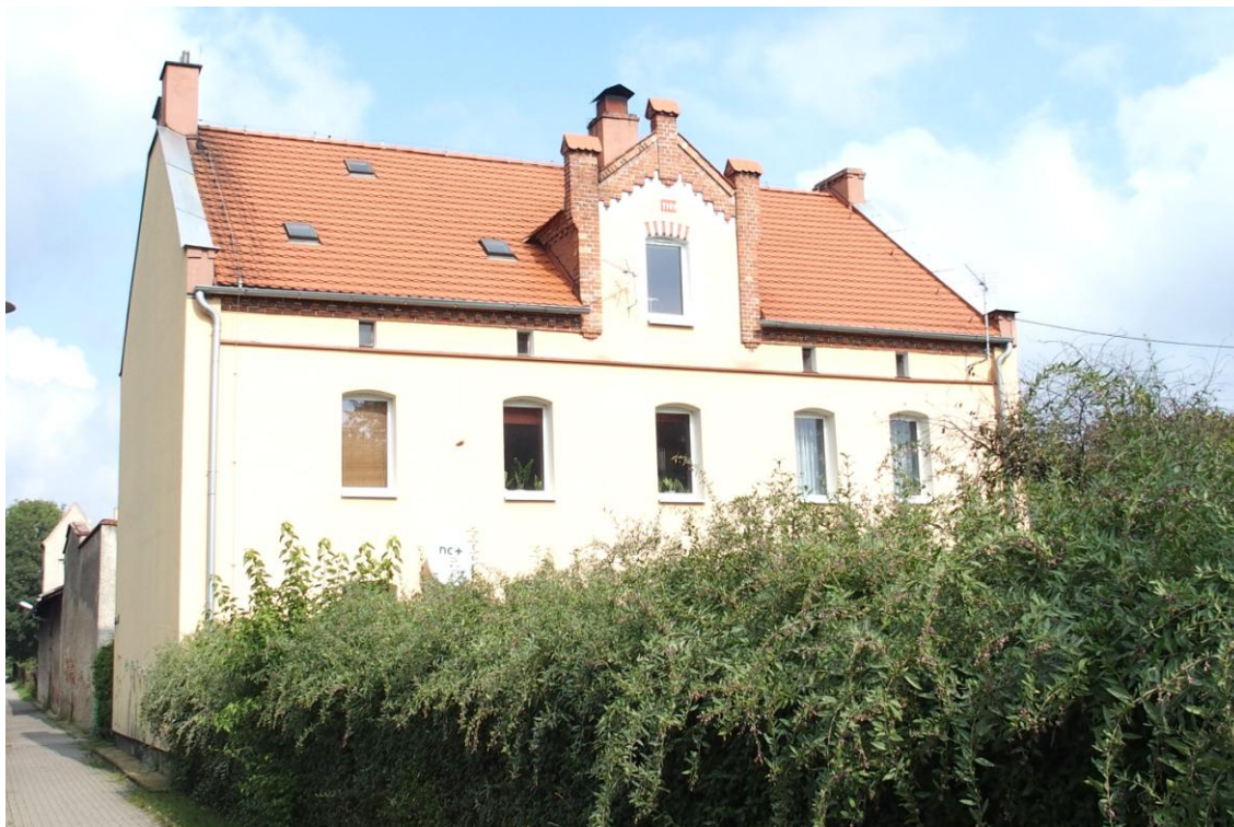
Widok budynku od południowego - zachodu
