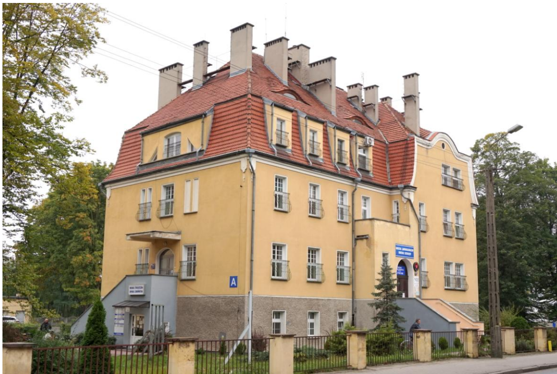
Widok budynku od południowego - wschodu
