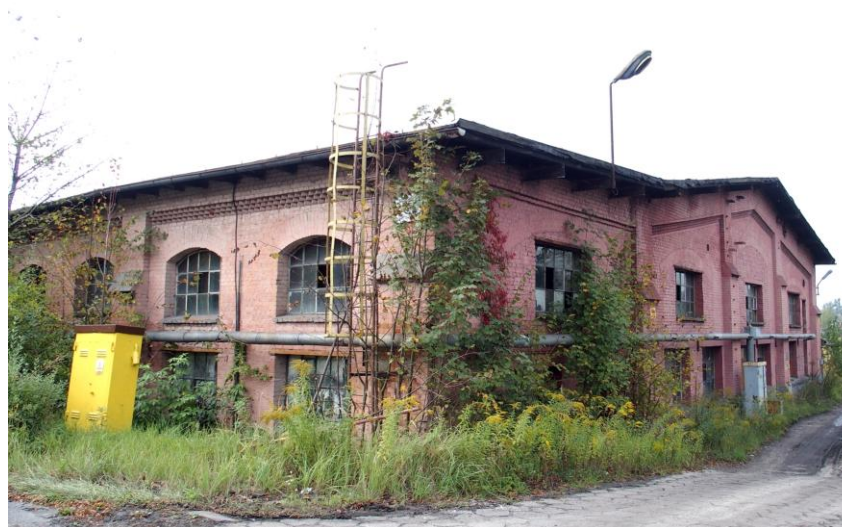
Widok budynku od południowego - wschodu
