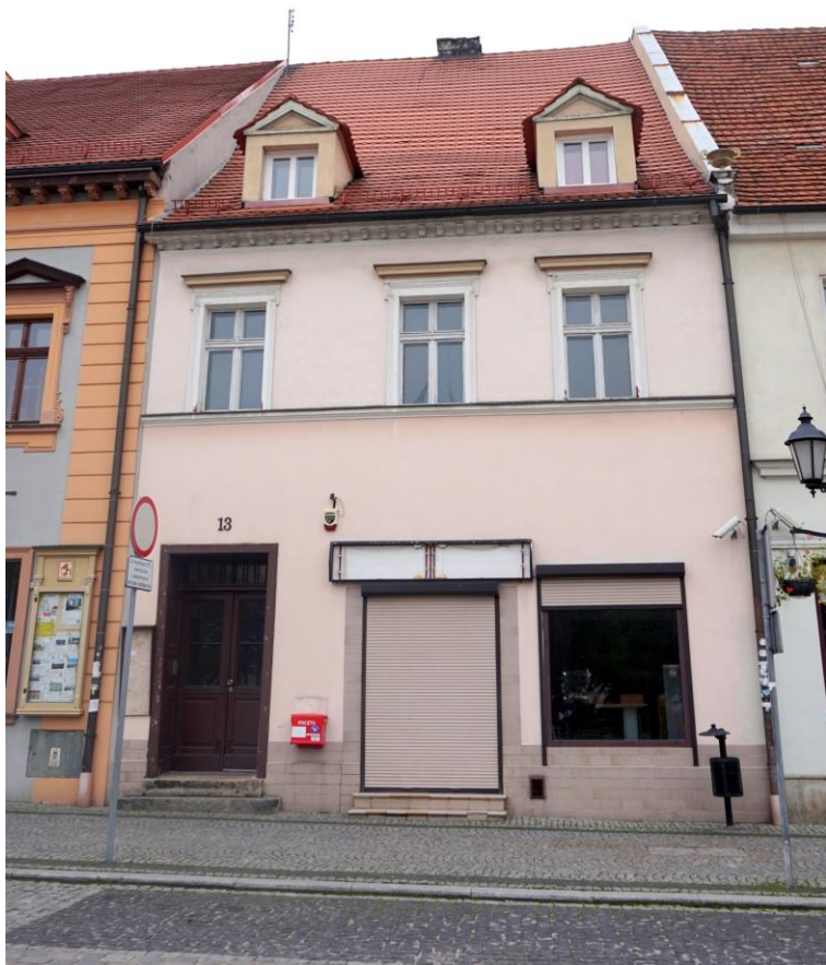
Widok budynku od wschodu
