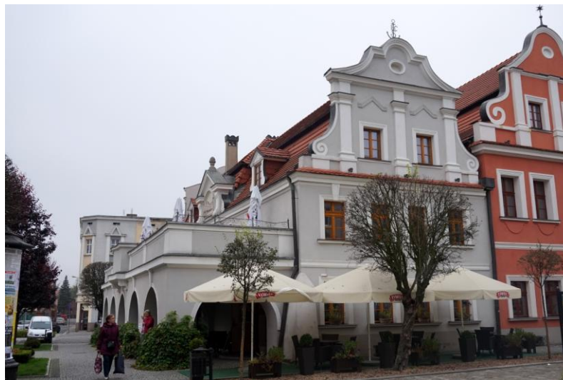
Widok budynku od południa
